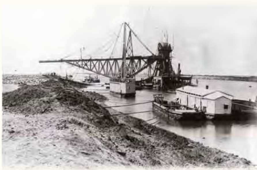
Izgradnja Sueskog kanala
