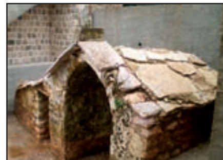
Ostaci originalnog krovnog pokrivača od kamenih ploča na sjevernoj strani krova kapelice
